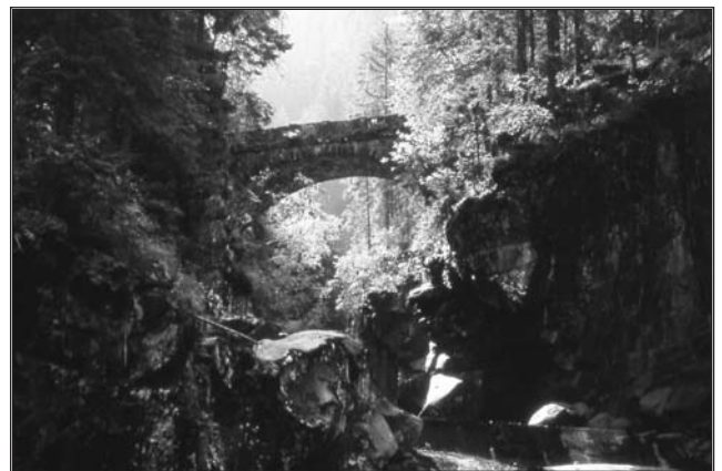
Ponte della Lizata sul Travignolo (1893).
