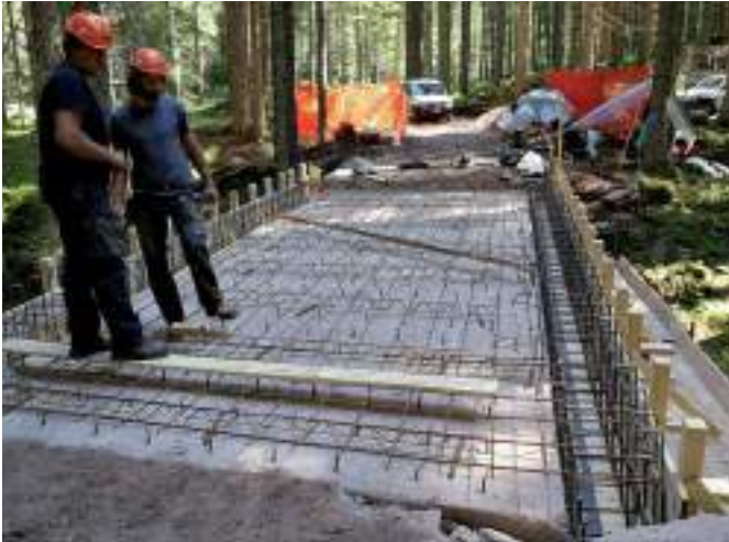
Rifacimento del ponte Valon.
