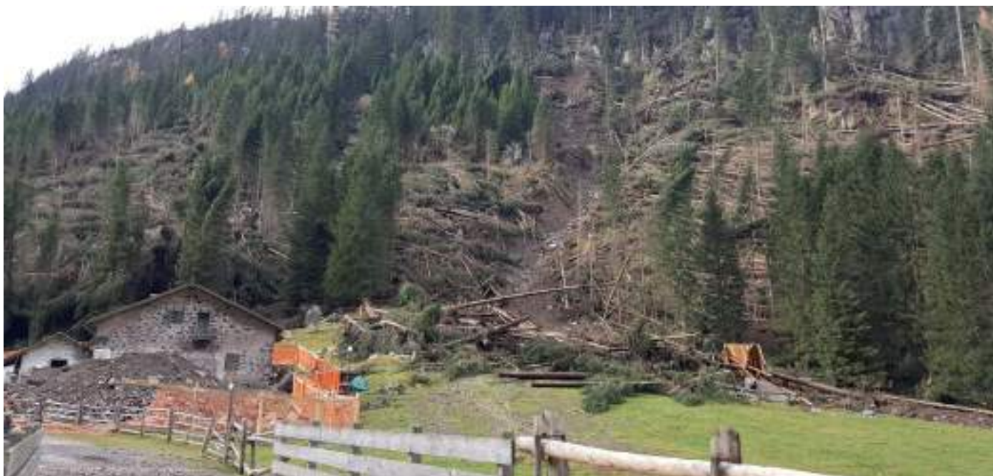
La chiesetta alpina di Valmaggior distrutta dalla frana
