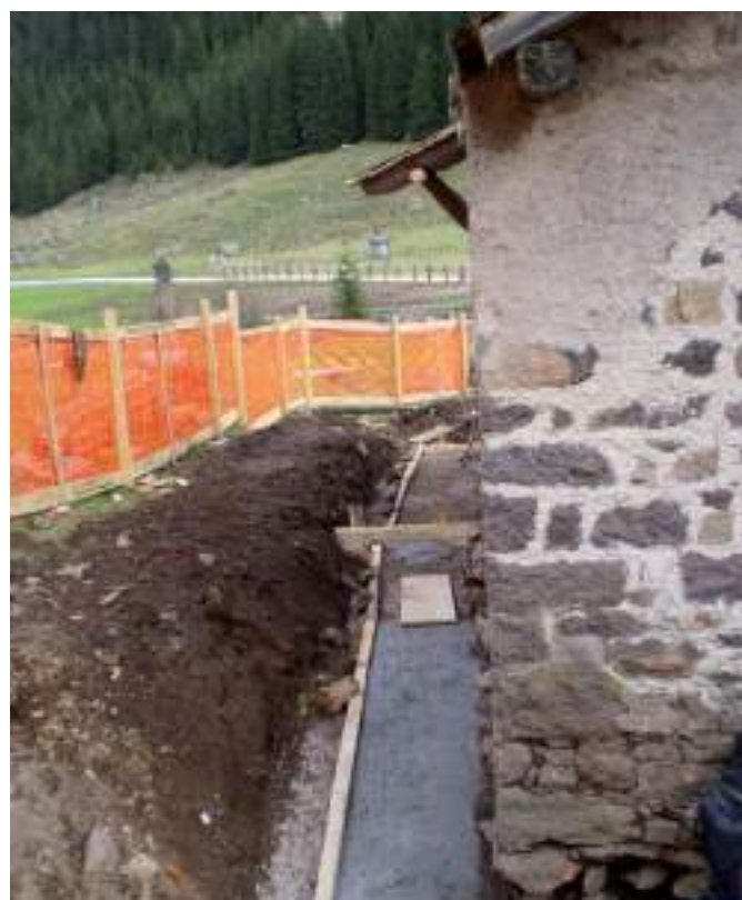
Lavori a malga Valmaggioro.
