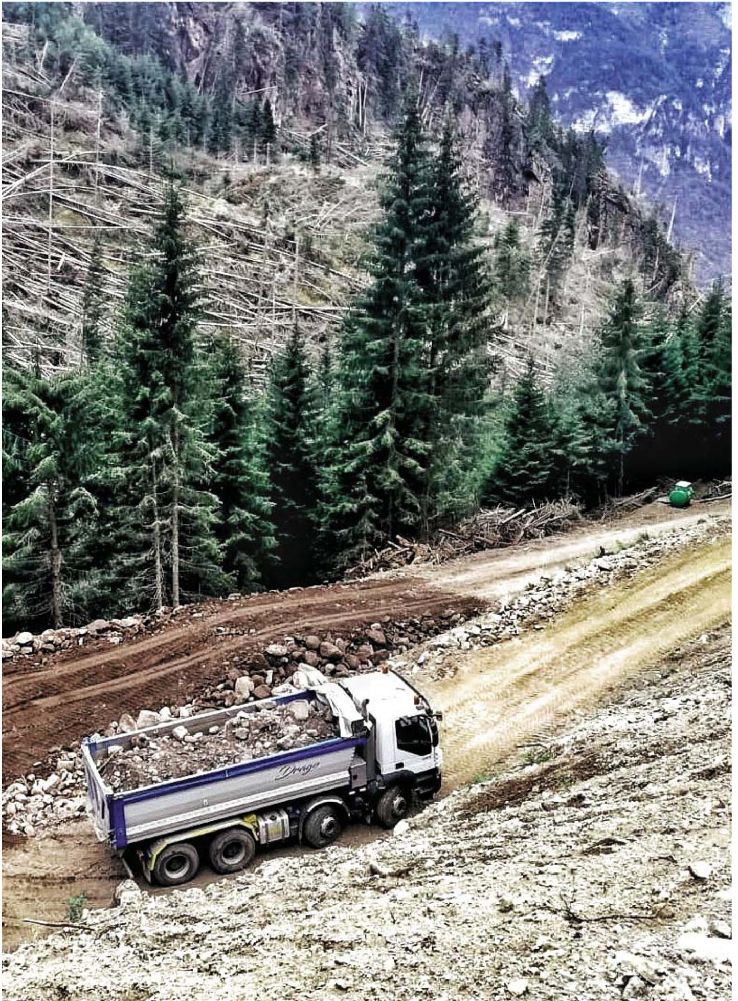
I lavori sono stati pesantemente condizionati dall'andamento meteo di fine stagione e con l'abbondante e persistente presenza, sulle rampe a monte, di acque di scorrimento superficiale che si infiltravano nel corpo stradale. La prossima stagione si completerà l'intervento, con sistemazioni di entità più contenute, sulle strade Lavazé - Rio Nero e Lavazé - Palù Longa.
