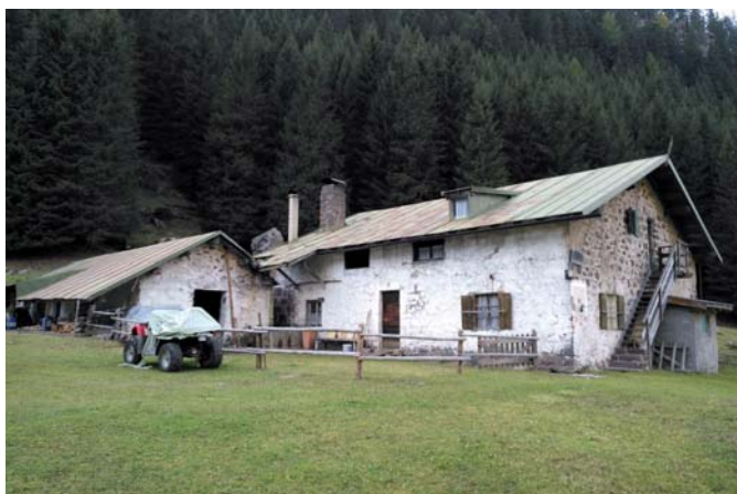
Gli edifici da recuperare a Malga Valmaggiora
